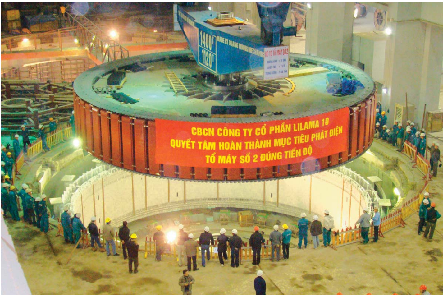
Lắp đặt Ro to tổ máy số 2 tại Thủy điện Sơn La
